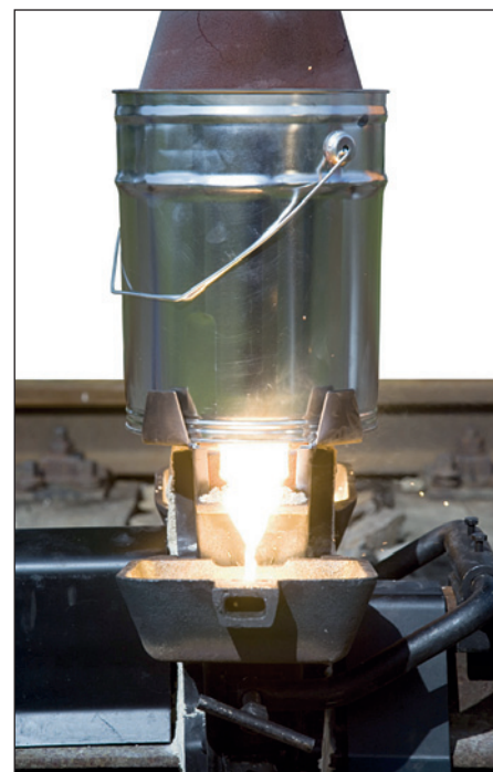
Abb. 2: Einlaufen des flüssigen Thermit-Stahls während des Schweißvorgangs
