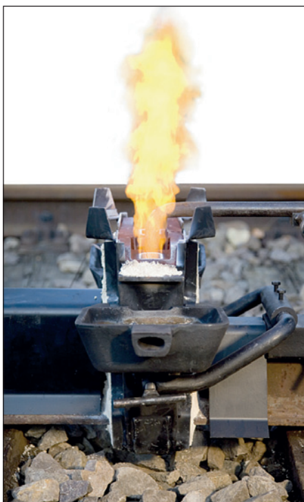
Abb. 1: Vorwärmung einer SkV-Elite-Schweißung
